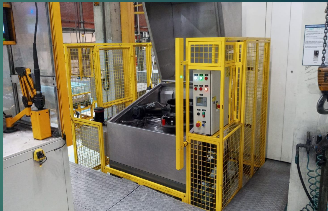
Equipamento instalado no cliente
